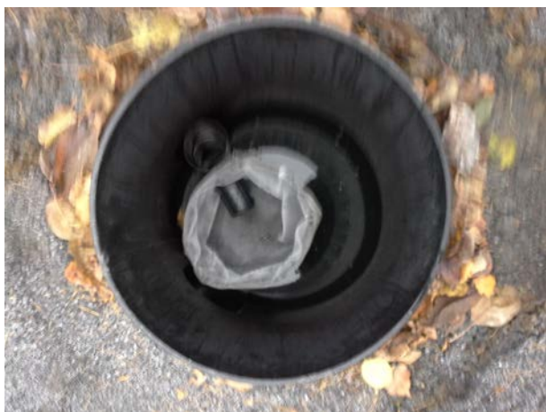
Kuva 5. Vesi virtaa Biojussi-sakosuodatinkaivon suodatinpussin läpi, jolloin suodatinpussiin jää pesuvesien kiintoainetta. Suodatinpussi tulee tyhjentää ja pestä ennen talvea.
