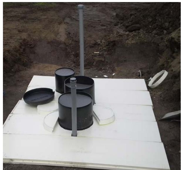
Kuva 4. Routaeristeet on asennettu kaivojen ympärille. Kuvassa näkyy Biojussi-Mökki 1050-puhdistamo.
