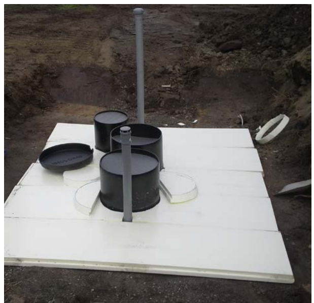
Kuva 4. Routaeristeet on asennettu kaivojen ympärille.
