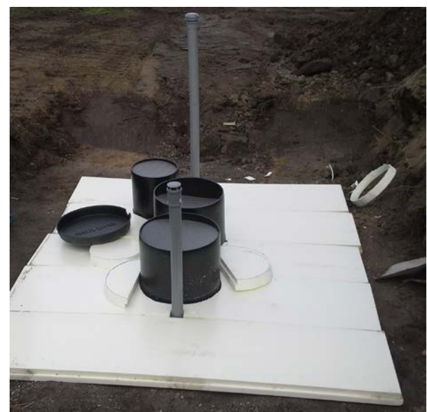
Kuva 4. Routaeristeet on asennettu kaivojen ympärille.
