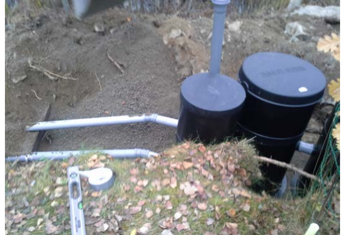
Kuva 2. Kalkkisuodattimesta ja näytteenottokaivosta lähtee 2 putkea purkupaikkaan. Kalkkisuodattimen poistoviemäriputkeen on liitetty tuuletusputki.
