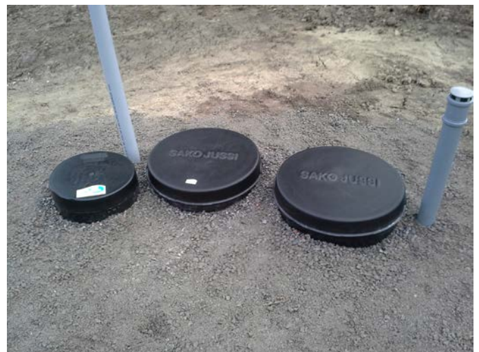
Kuva 4. Kaivonkannet ovat maan tasalla ja tuuletusputket ylittävät lumirajan yläpuolelle. Kuvassa näkyy Biojussi-Mökki 1050 -puhdistamo.
