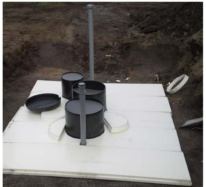
Kuva 3. Routaeristeet on asennettu kaivojen ympärille. Kuvassa näkyy Biojussi-Mökki 1050 -puhdistamo.
