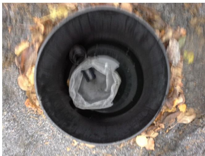
Kuva 5. Vesi virtaa suodatinkaivon suodatinpussin läpi, jolloin suodatinpussiin jää pesuvesien kiintoainetta. Suodatinpussi tulee tyhjentää ja pestä ennen talvea.
